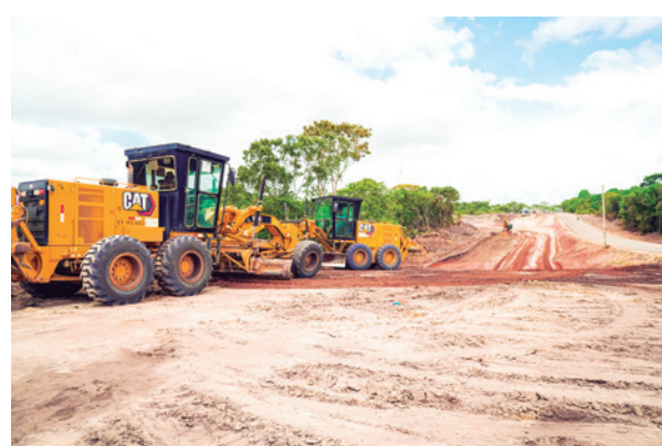
Serviços de terraplanagem estão 40% concluídos
